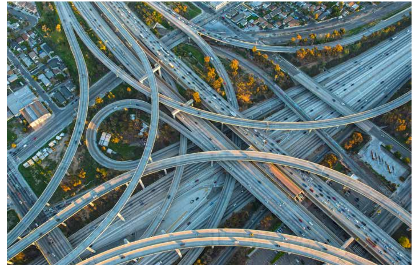
Rijkswaterstaat is een programma gestart om via het delen van data en het aanboren van nieuwe databronnen te komen tot een datagedreven assetmanagement.
